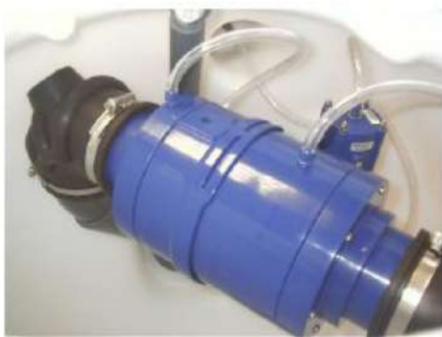
Εικόνα 4. Μονάδα βαλβίδας κενού 75 mm (3") εγκατεστημένη στον ξηρό θάλαμο φρεατίου
