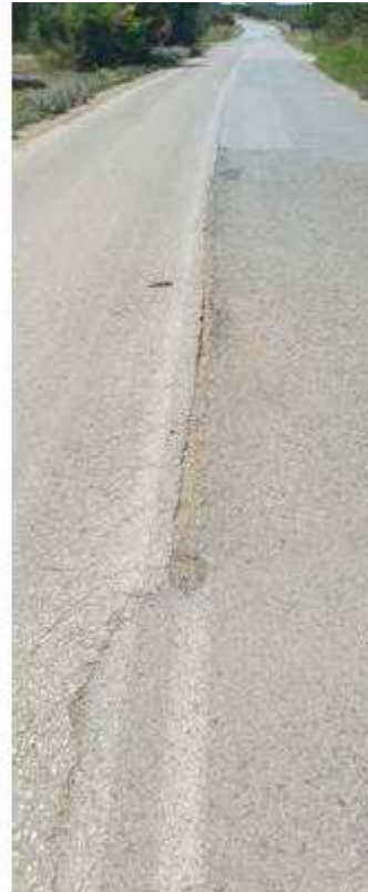
Φωτ2. Ρηγμάτωση και εκτεταμένη αποσάθρωση στο κέντρο της οδού
