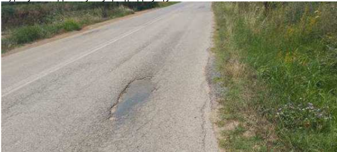
Φωτ.5 Ρηγμάτωση - καθίζηση - διάβρωση στην οριογραμμή της οδού.
