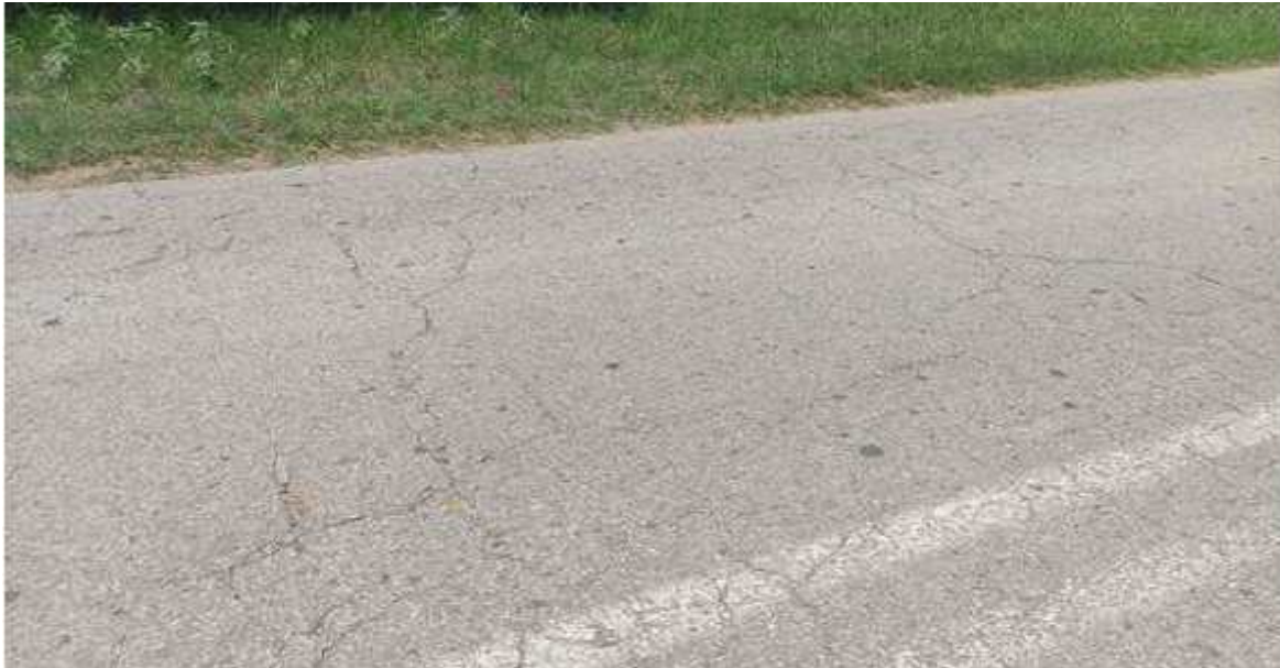
Φωτ. 7 Εγκάρσιες και διαμήκεις ρηγματώσεις ευρείας κλίμακας.
