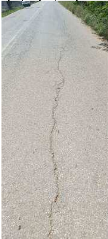
Φωτ1. Ρηγμάτωση στη λωρίδα κυκλοφορίας
