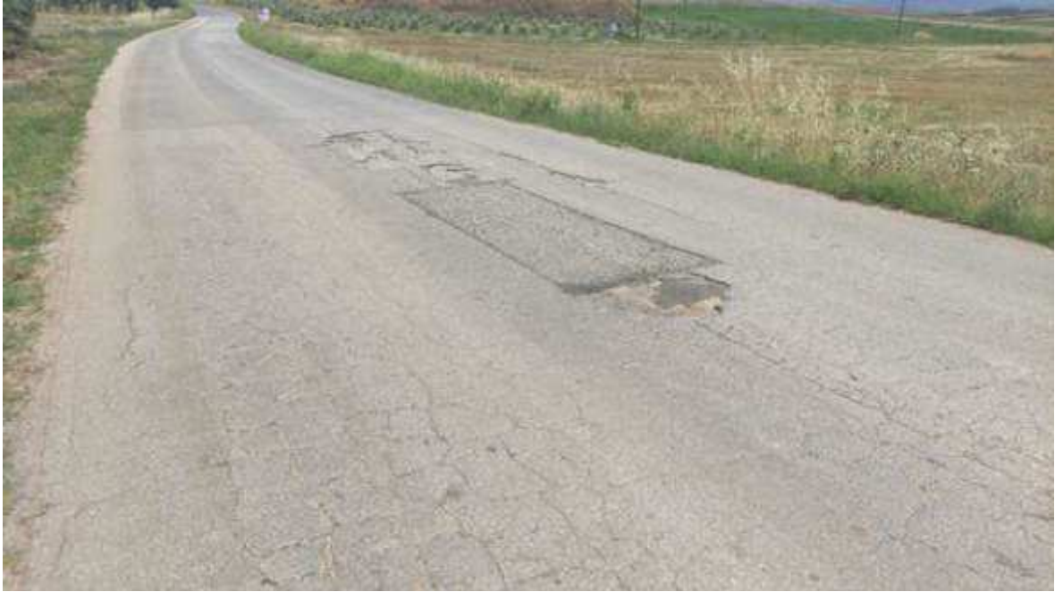
Φωτ. 9 Φθορές (λακούβες) με συνεχή απώλεια της επιφανειακής στρώσης.
