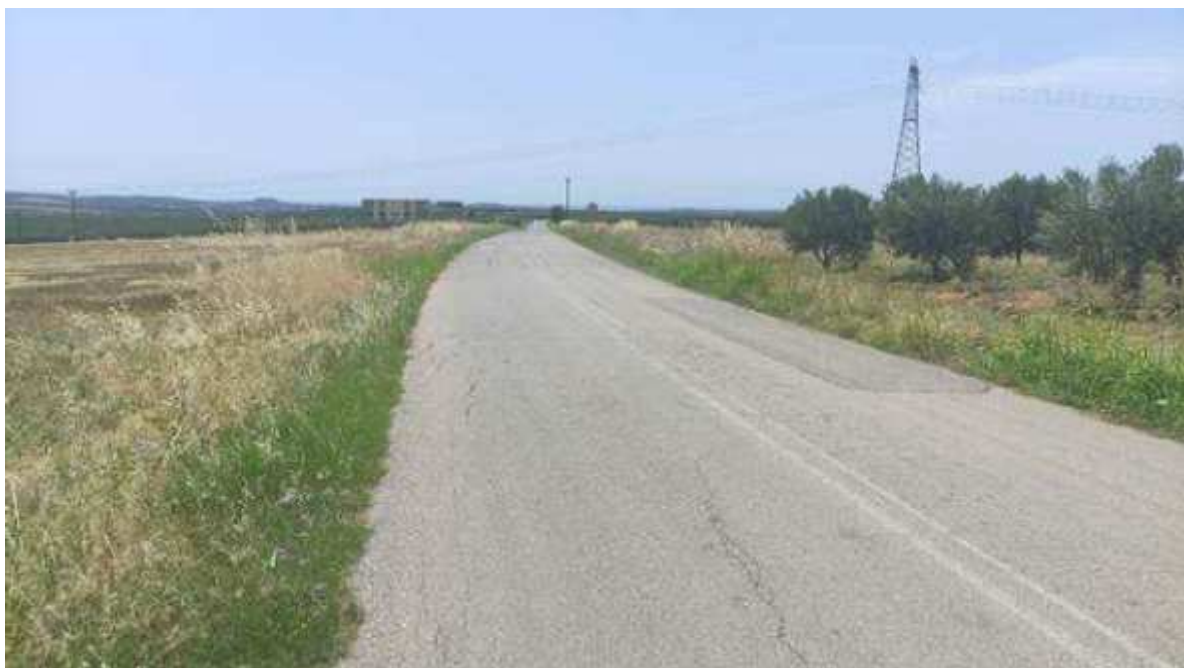
Φωτ. 8 Εγκάρσιες και διαμήκεις ρηγματώσεις ευρείας κλίμακας.
