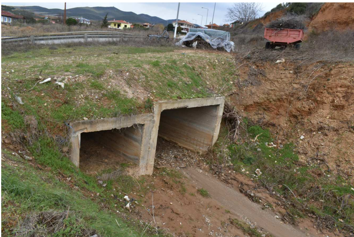
Φωτογραφία 4.5: Υφιστάμενο τεχνικό προς καθαίρεση στη θέση του νέου κιβωτοειδή ΚΙΒ ΟΧ2
