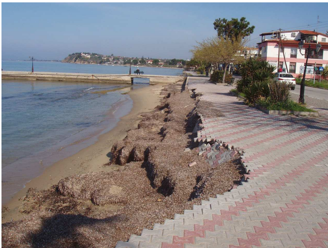
Φωτ. 9 Καταστροφή του τοίχου και του χώρου αναψυχής (όψη προς τα βόρεια)
