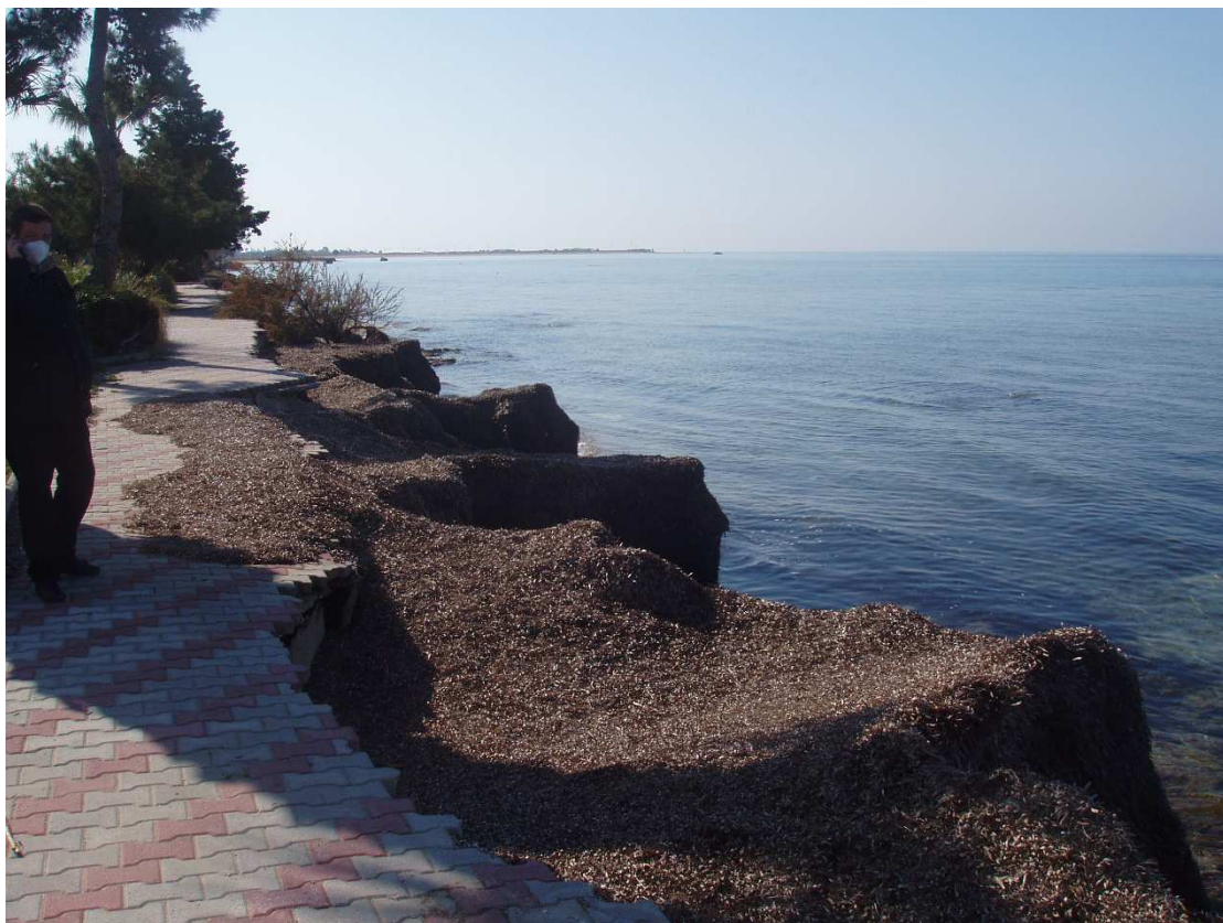
Φωτ. 10 Καταστροφή του τοίχου και του χώρου αναψυχής (όψη προς τα νότια)
