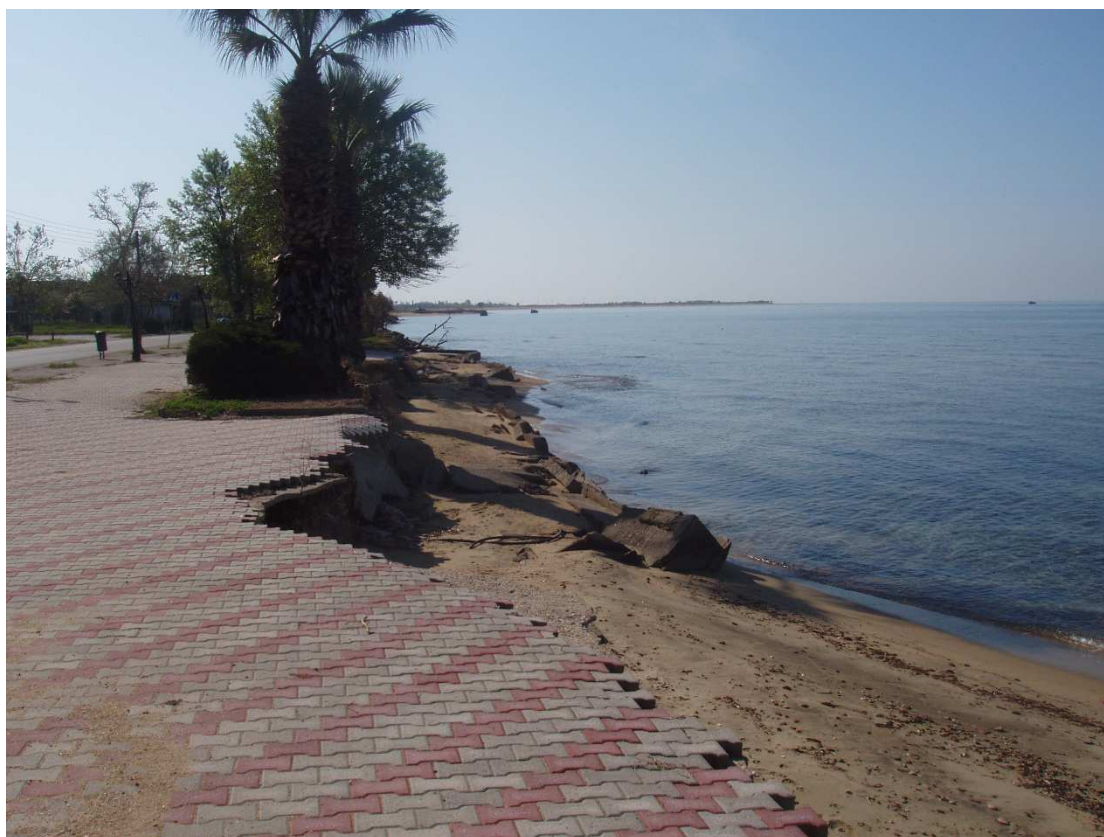
Φωτ. 12 Καταστροφή του τοίχου και του χώρου αναψυχής (04/2021)
