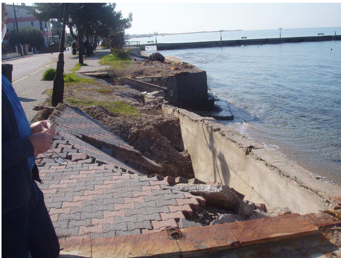
Φωτ. 6 Καταστροφές στον τοίχο και την επίστρωση βόρεια του προβλήτα
