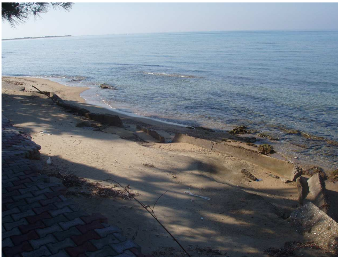
Φωτ. 11 Καταστροφή του τοίχου και του χώρου αναψυχής
